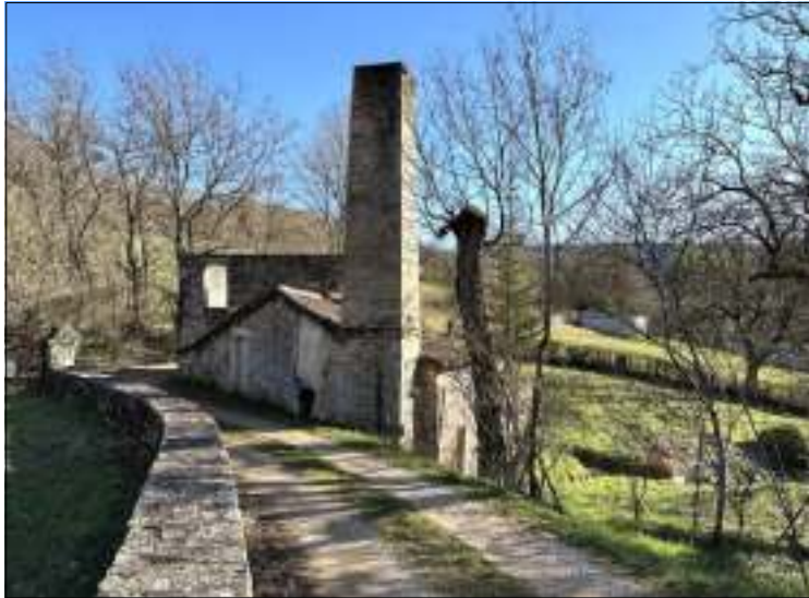
▲ Saint-Antonin : près de Nibouze, ruines de la cartonnerie (photo D.P.).
