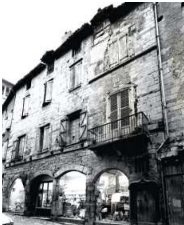
▲ Un balcon sur une maison ancienne à Saint-Antonin.
