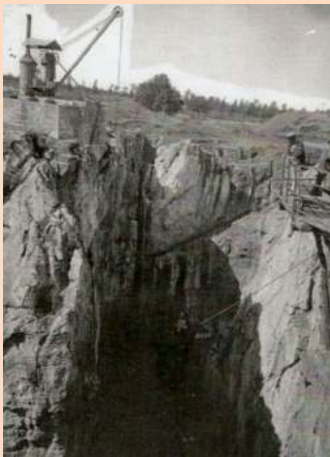
▲ Saint-Antonin : exploitation de phosphates ; on remarquera la grue à vapeur.
