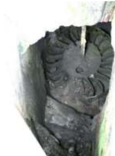
Un des rouets du moulin, encore visible de la rue. Le bassin intérieur présumé en sous-sol (comme au moulin du Bessarel) est complètement occulté par la dalle de béton coulée pour accueillir les véhicules du centre de secours. ►
