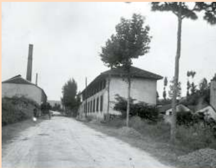
▲ Le Martinet en 1896. On remarque les cheminées indiquant la présence d'une machine à vapeur installée en 1863.
