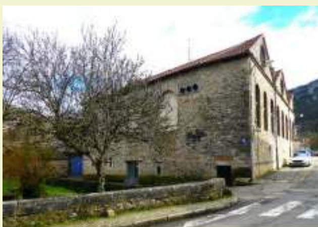
▲ L'usine des Claustres en son état actuel. La partie moulin est située à l'arrière (ici à gauche sur la photo). On voit l'arrivée du courant électrique (les trois isolateurs).
